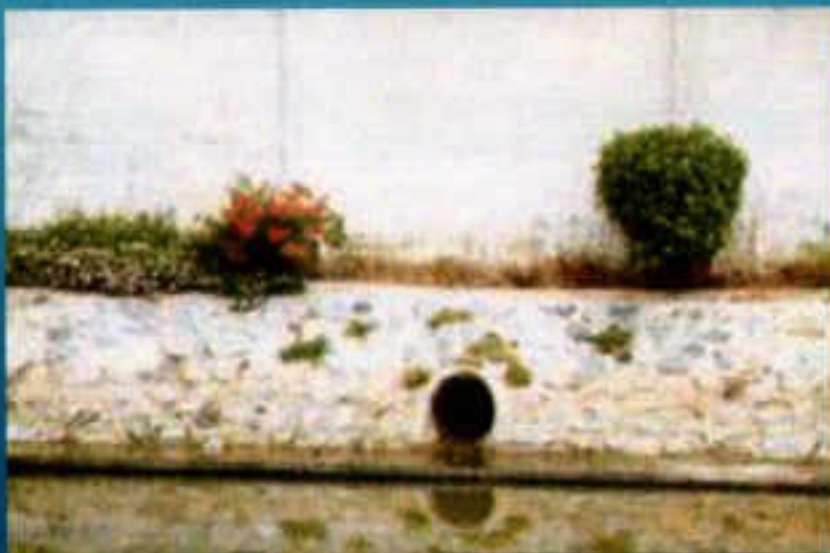
เขื่อนแบบสมอยึดด้านหลังและมีเรียงหิน (Anchorage)
